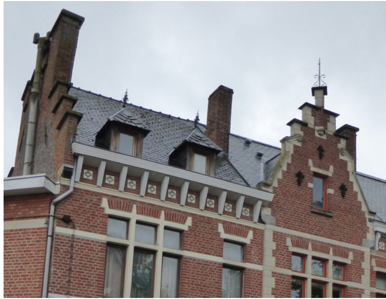
bestaand dakvlak met dakkapellen nr 13 (links)
