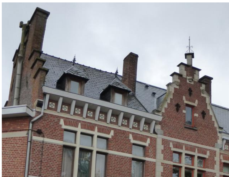
bestaand dakvlak met dakkapellen nr 13 (links)
