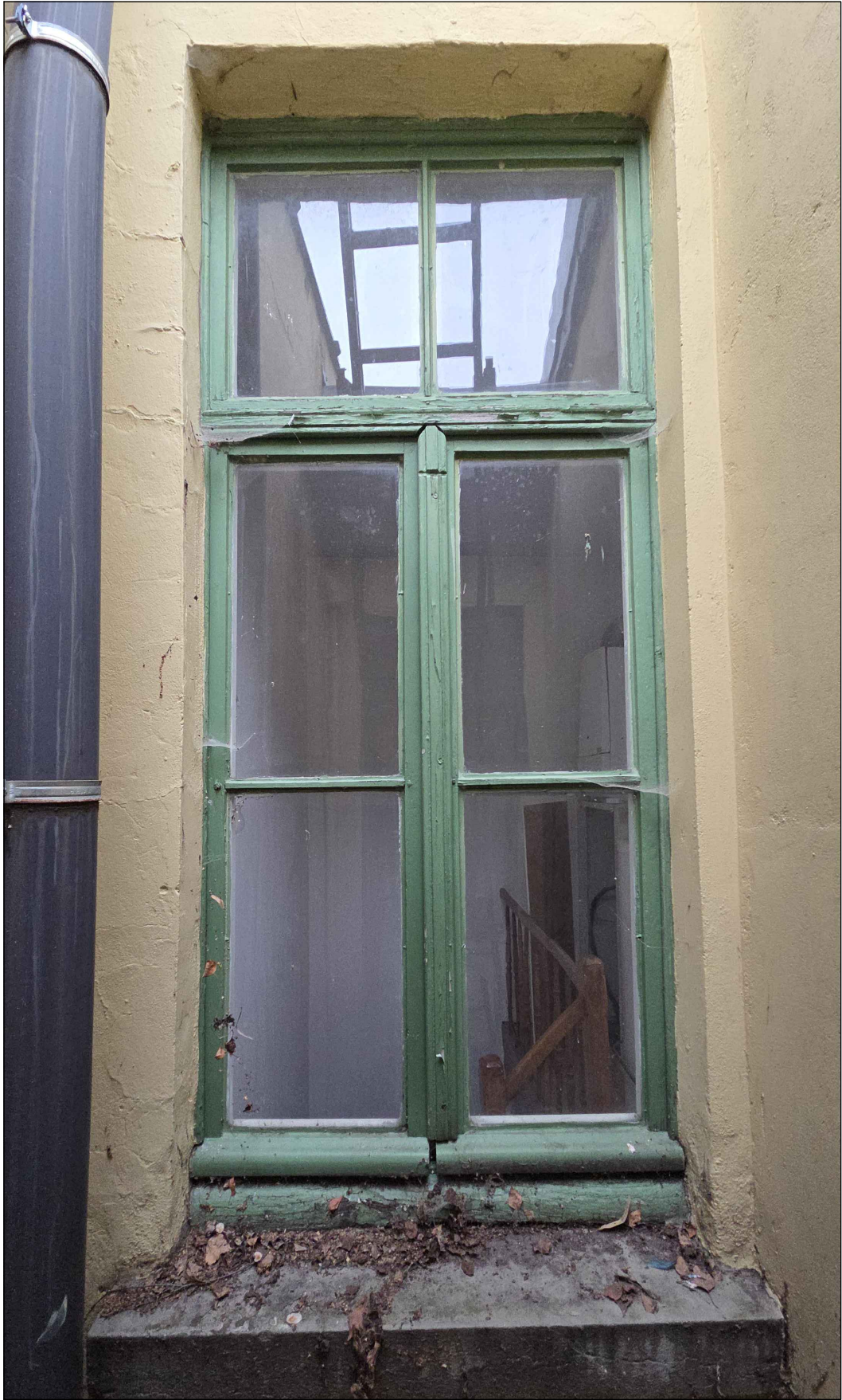
niveau +3 lichthapper (origineel schrijnwerk): exterieur
