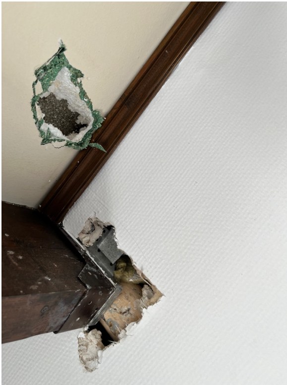
Stalen kolom waarop dakconstructie rust
