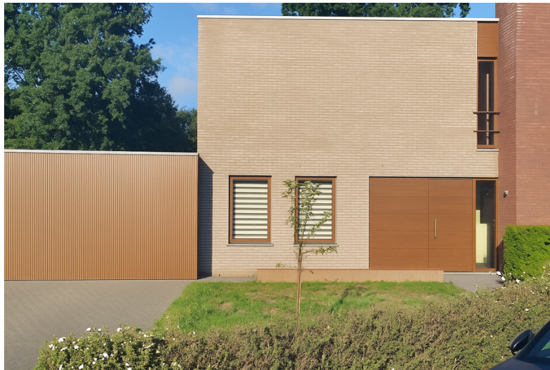
Nieuw situatie na plaatsing van poort.
