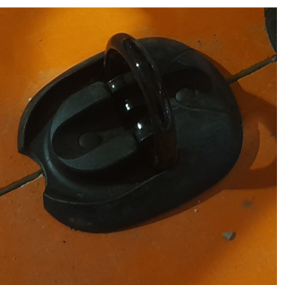
ringen in grond ter bevestiging fietslot
